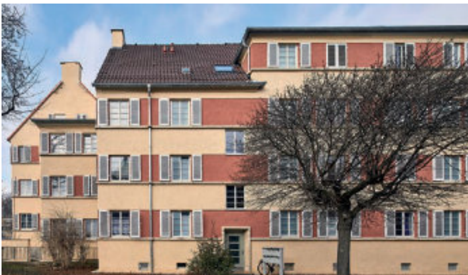
Denkmalgerecht saniert. © Friedemann Rieker
