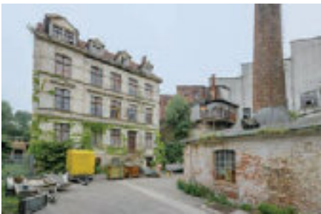
Zustand vor dem Umbau © Jann Höfer
