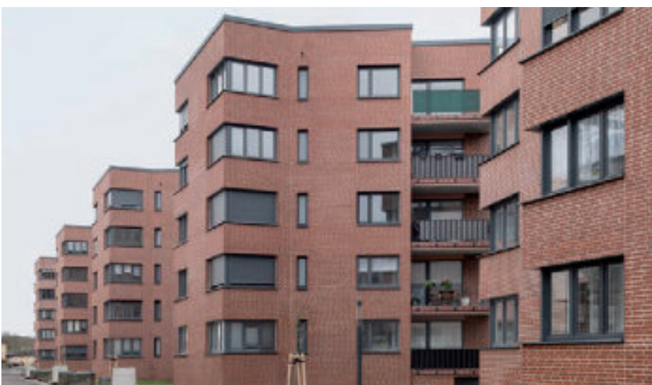
Blick auf die Mehrfamilienhäuser aus der Straße Zum Inselblick © Hannes Heitmüller
