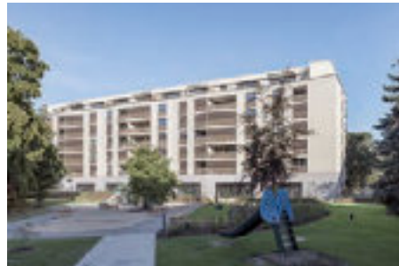
Außenanlagen im Innenhof des Wohnquartiers © Till Schuster
