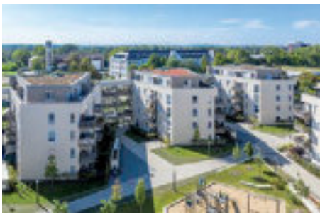
Gebäudefinger mit Lärmschutzloggien © Martin Gaissert
