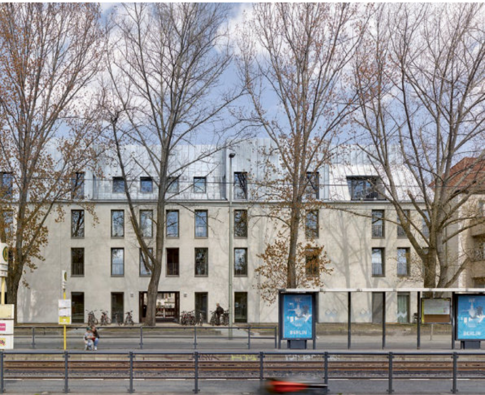
Blick von der Hauptstraße auf Haus 3 mit dem Durchgang in den Garten © Stefan Müller
