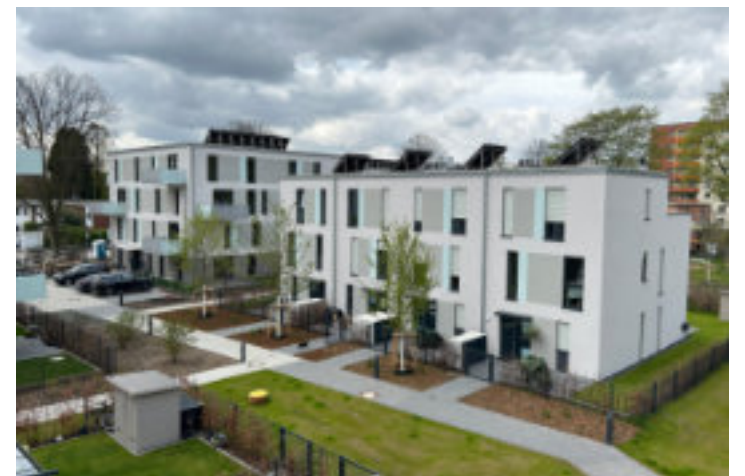
Mehrfamilienhaus und Reihenhäuser 3.BA
