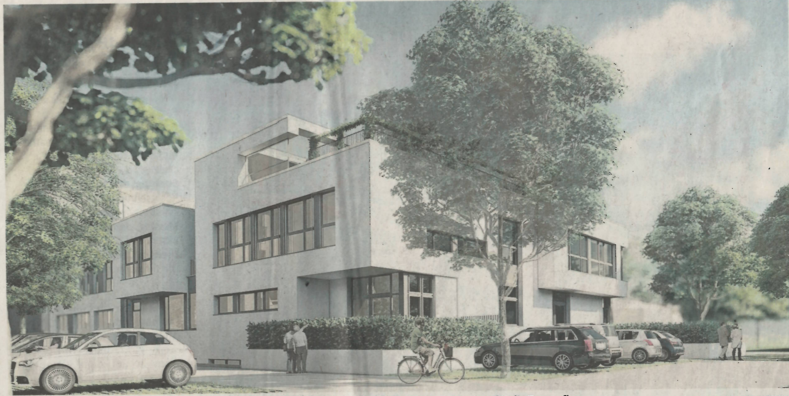
Die Diakonie Neuss-Süd erweitert ihr Heinrich-Grüber-Haus: Das Altenheim bekommt einen Neubau für die Tagespflege.
