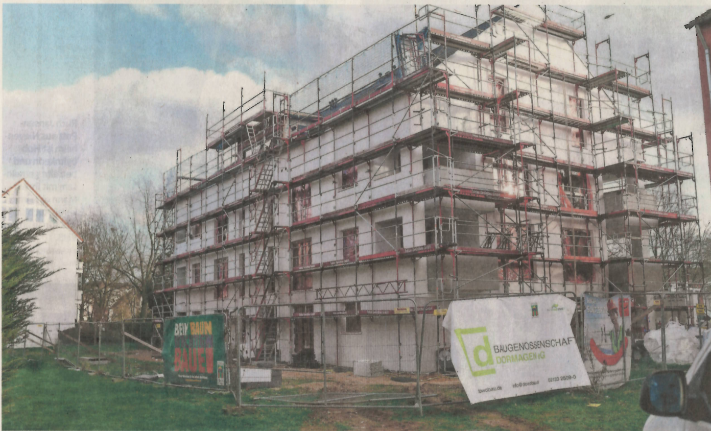
Die Baugenossenschaft wird im Frühjahr am Hagedorn in Horrem 14 neue Wohnungen fertiggestellt haben.
